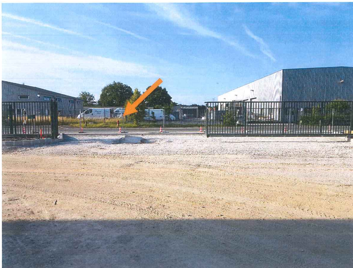
MENUT ST CYR EN VAL – Poteau Incendie sur le trottoir en face l'entrée principale (Vue 2)
